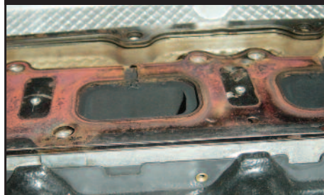
Figura 4: No habían orificios que pudieran estar bloqueados. Se usaron empaquetaduras dobles durante una reparación previa, con ranuras cortadas donde los orificios debían haber estado.
